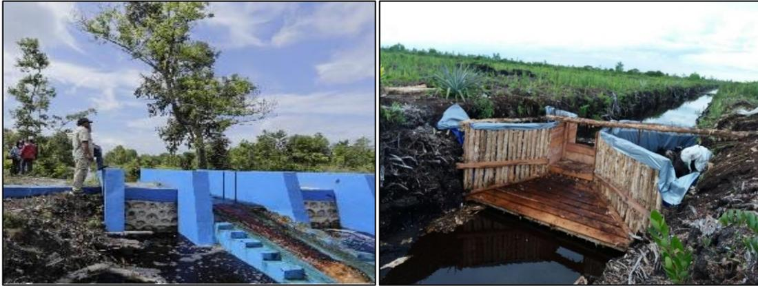
**Gambar 5.5. Sekat kanal yang dibangun sebagai bagian restorasi hidrologi**
