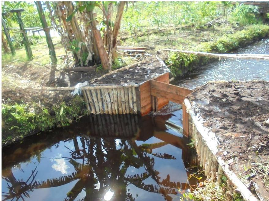
**Gambar 10. Proses Pembangunan Dam 1 (bagian paling hilir)**
