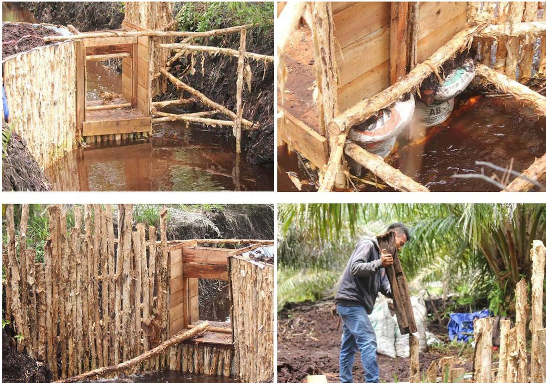
**Gambar 9. Proses Pembangunan Sekat Kanal 2**
